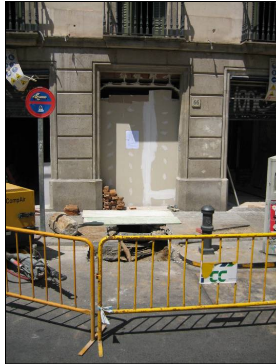
FOTO 2. Situació de la rasa davant la façana.
