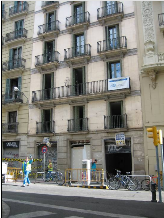
FOTO 1. Vista exterior de l'immoble.
