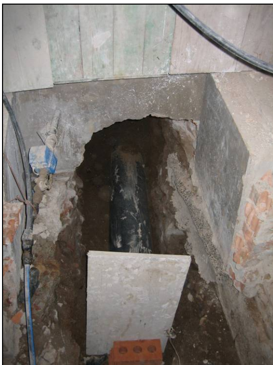
FOTO 7. Detall de l'ampliació del forat practicat a la fonamentació de la façana per a la col·locació del tub de pvc.
