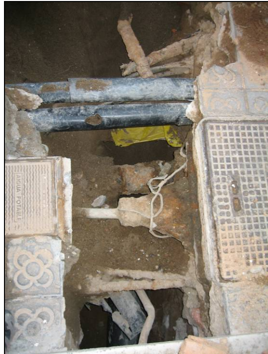
FOTO 4. Detall de la gran quantitat de serveis apareguts.
